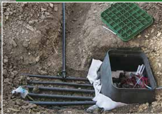
Šachtice s elektromagnetickými ventily a přívodem elektřiny
