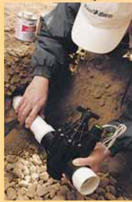
Instalace hlavního uzávěru
