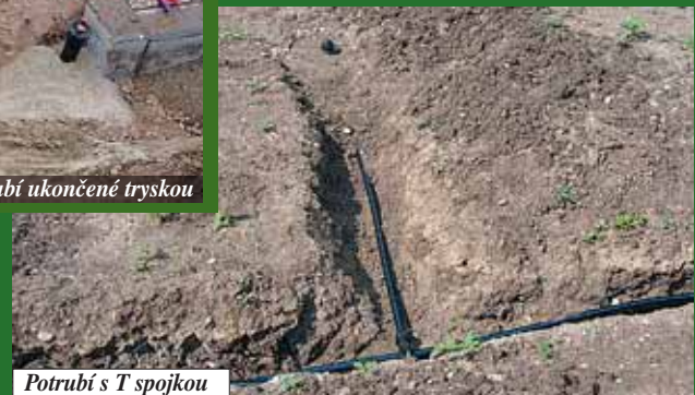
Potrubí s T spojkou
