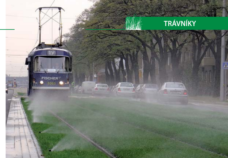
Travnaté tramvajové pásy s kvalitní závlahou zvyšují množství zeleně ve městech, významně snižují prašnost a hlučnost na ulicích a jsou zároveň velmi estetické
